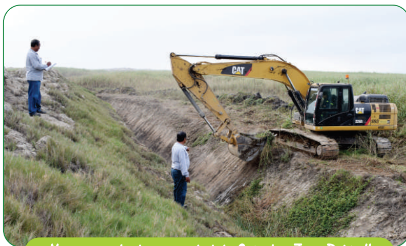
Mejoramiento de capacidad de Colector Juan Pablo II
